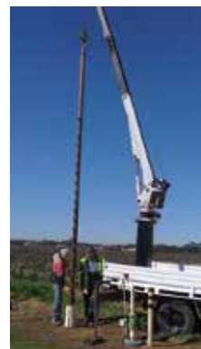
Installazione pompa sommersa
