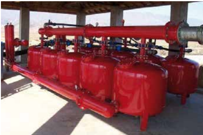
Batteria di filtri a quarzite singola camera
